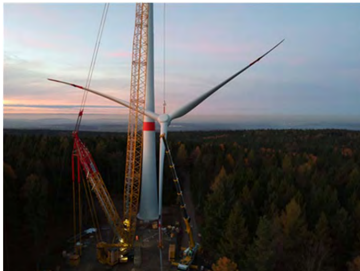
WEA 10 – Installation Stern (Rotor) (Quelle Wirsol Windpark Straubenhardt GmbH & Co. KG)
