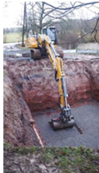
Grabung für die neue Löschwasserzisterne
