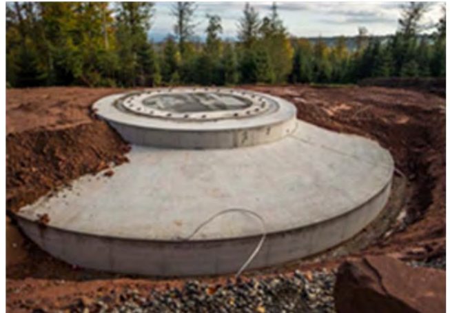
WEA 13 – Fundament (Quelle: Wirsol Windpark Straubenhardt GmbH & Co. KG)
