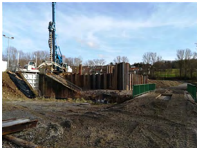
Dammschüttung und Abspundung (Gemeinde Remchingen)
