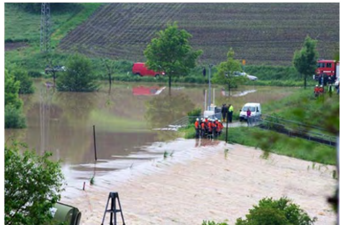
Hochwasser 2013: Im Hintergrund die L 339; die Personen im Vordergrund stehen zum Teil auf dem Durchlassbauwerk. (Homepage Gemeinde Remchingen)
